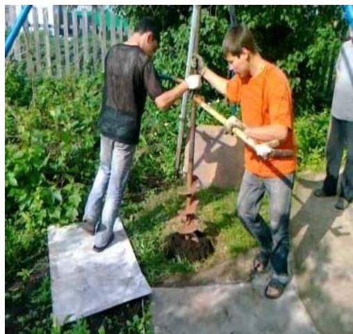
Рис. 2. Процесс ручного бурения скважины
